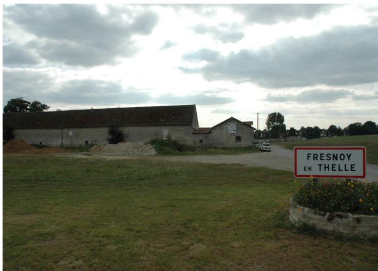
Vue de l'entrée Est, depuis la RD 929
