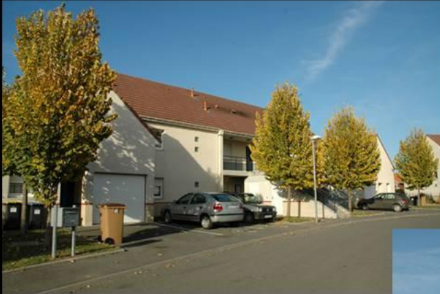
Le logement locatif et collectif
